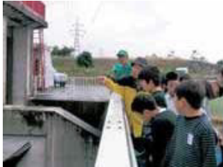
▲下条用水をたどりました。頭首工の仕組みのすごさに驚きました。
